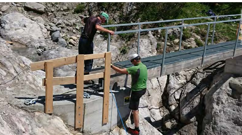
Die Brücke über den Gasillbach an der Augsburger Hütte wurde aufgrund von Extremwetterereignissen immer wieder weggerissen. Jetzt wurde sie mit Betonfundamenten und speziellen Sicherungsseilen versehen
