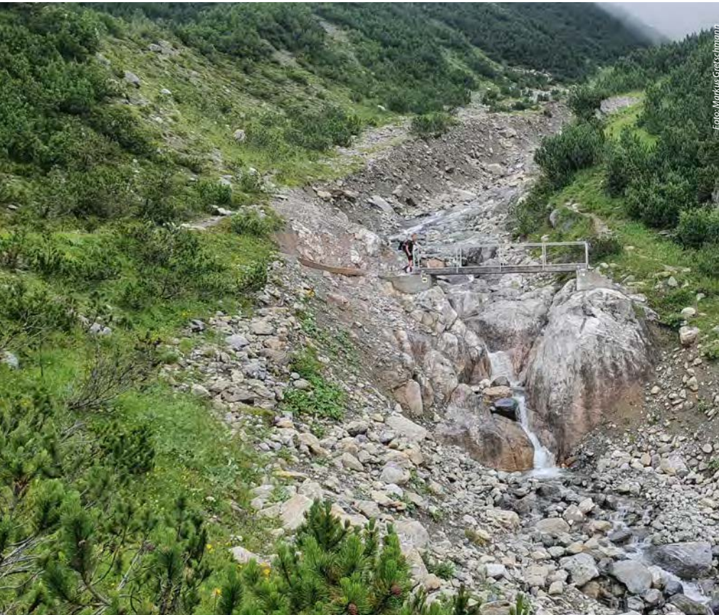
Die Brücke über den Gasillbach an der Augsburger Hütte wurde mit einem Betonfundament und speziellen Seilen vor Abrutschen gesichert.
